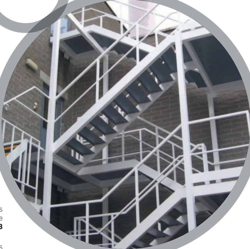
Escaliers de secours
