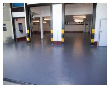
Sol d'un entrepôt de produits laitiers restauré avec Belzona 5231
