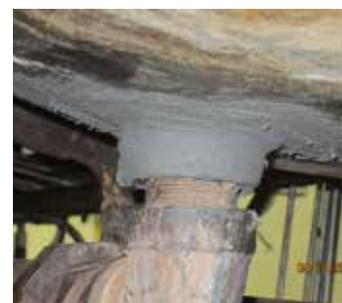
Des trous étaient apparus dans le joint de soudure d'une chaudière de procédé sous l'action de la corrosion. Belzona 1511 a été utilisé pour réparer durablement les chancres.
