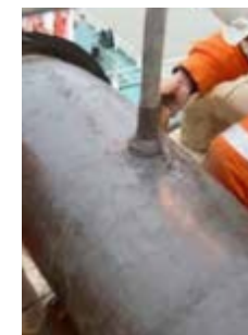
Belzona 1251 (HA-Metal) Composite de réparation époxy hautes performances activé thermiquement pour les applications directes sur des surfaces métalliques chaudes.
