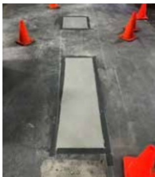
Belzona 4111 (Magma-Quartz) Système de réparation/reconstruction de consistance magma pour la réparation et le resurfaçage du béton et de la pierre.
