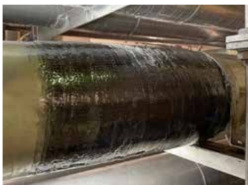
Belzona 1983 Résine haute température pour des températures d'application de 5 °C (41 °F) à 40 °C (104 °F) et des températures de fonctionnement jusqu'à 150 °C (302 °F).
