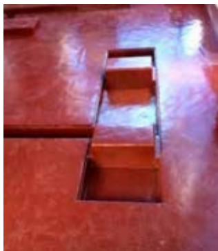
Belzona 4181 (AHR Magma-Quartz) Mortier de réparation du béton à base d'époxy résistant aux acides et à la chaleur.
