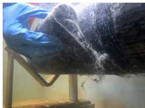
Belzona 1984 Résine tolérante de l'état de surface pour des températures de service allant jusqu'à 50 °C (122 °F) et adaptée à une température d'application minimale de 5 °C (41 °F).
