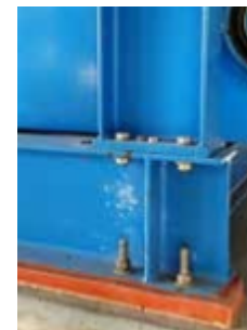
Belzona 7111 Matériau de calage/jointement sous forme coulante conçu pour s'étaler uniformément sur les surfaces inégales afin de leur conférer une résistance aux chocs physiques et thermiques.
