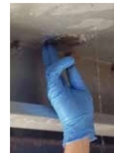
Belzona 9611 Système à durcissement rapide pour un colmatage d'urgence des fuites à basse pression, avant une réparation plus permanente.
