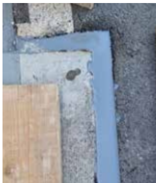
Belzona 4521 (Magma-Flex Fluid) Mastic d'étanchéité flexible et économique, à durcissement rapide, adapté à la construction et aux joints de dilatation sur des substrats horizontaux poreux tels que le béton.
