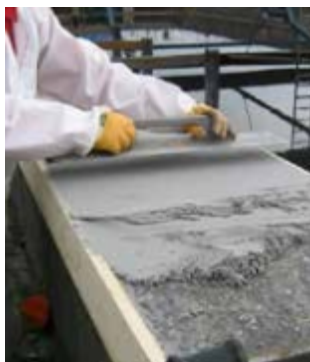
Belzona 4131 (Magma-Screed) Mortier de réparation du béton époxy résistant aux chocs et à l'abrasion.
