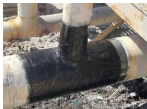
Belzona 1982 Résine à longue durée permissive d'utilisation pour des températures d'application de 20 °C (68 °F) à 40 °C (104 °F) et des températures de fonctionnement jusqu'à 80 °C (176 °F).
