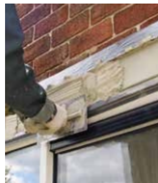
Belzona 4141 (Magma-Build) Mortier de réparation du béton à base d'époxy léger adapté aux applications verticales et en hauteur.
